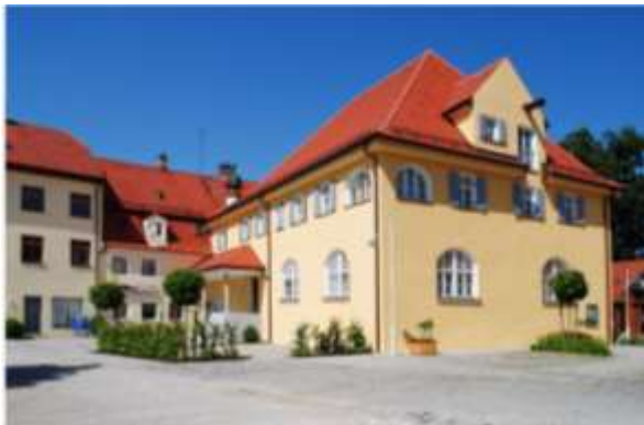
Archivbild, Blick auf das Saal- sowie Mansardengebäude des Schlossensembles Emersacker. 17
