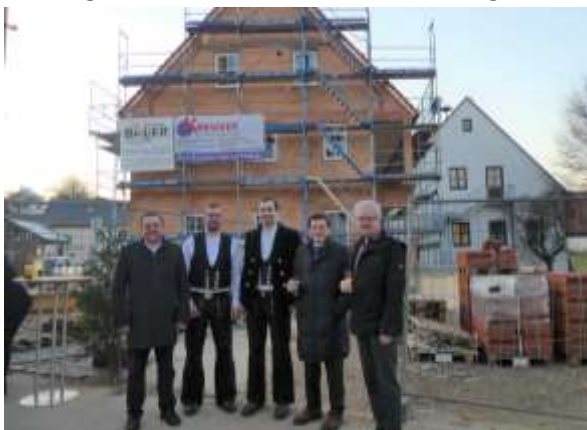
Hebauf beim Mehrzweckhaus der Gemeinde Heretsried. 13
